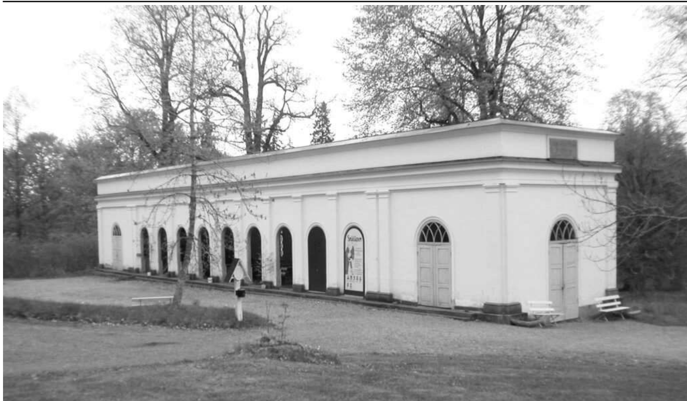
Medevi högbrunn 2006. Byggnaden från 1898 är 39 meter lång och 8 meter bred i empirstil. Brunnskaret är från 1678/1679. Wikimedia commons.
